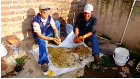
COMPACTACIÓN MP PARA LOS BM
