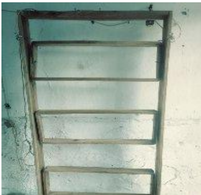
Ilustración 28 Instalación. Fuente (El autor, 2019).
