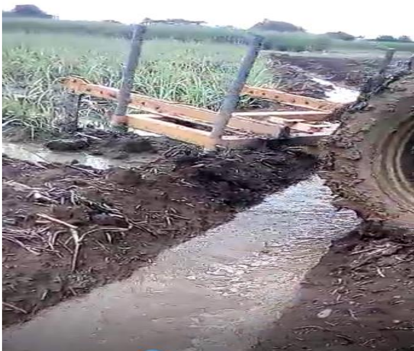
Figura 4. Proceso de evacuación del exceso de agua con el “despuntador”
