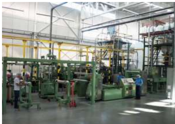
Fuente: Planta manufacturera. Sección metálica
