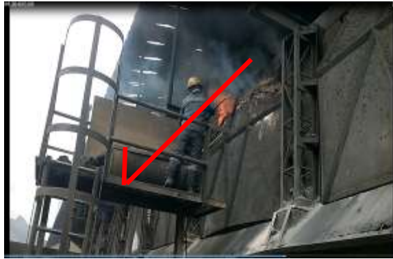
Figura N. 14 Postura correcta operación bajar puerta de salida y realizar sellado con arcilla
