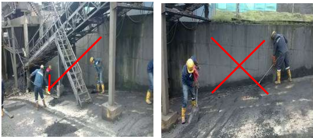
Figura N. 36 Postura correcta e incorrecta operación aseo tanques sedimentadores y bandas transportadoras
