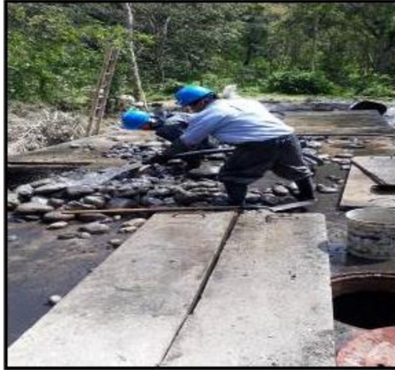
Figura 6. Mantenimiento PTAR Fuente: Unidad de servicios públicos
