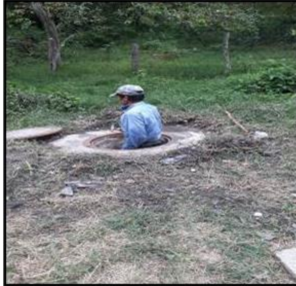
Figura 8. Mantenimiento PTAR Fuente: Unidad de servicios públicos
