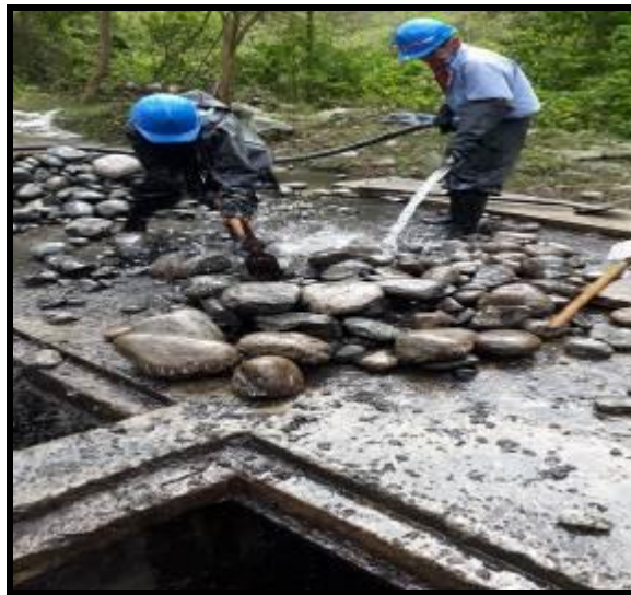
Figura 5. Mantenimiento PTAR Fuente: Unidad de servicios públicos
