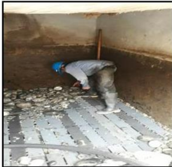
Figura 7. Mantenimiento PTAR Fuente: Unidad de servicios públicos
