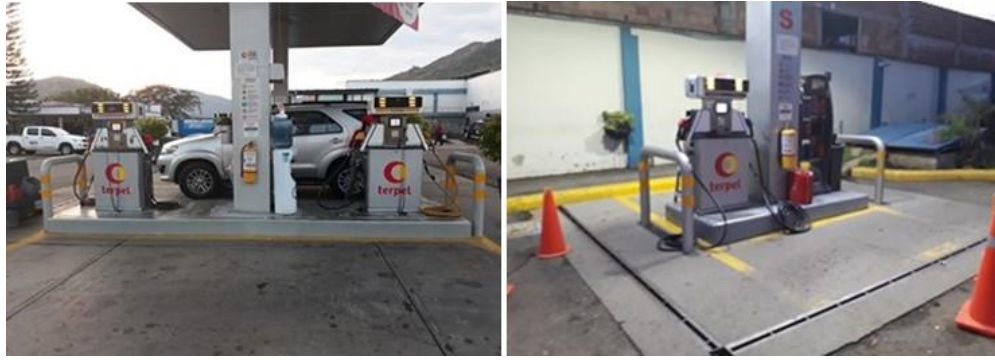
Figura 16. Surtidores de combustible
