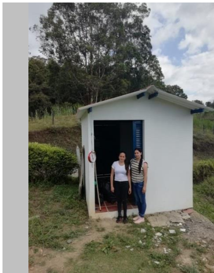
Imagen 19. Almacenamiento de residuos inorgánicos.
