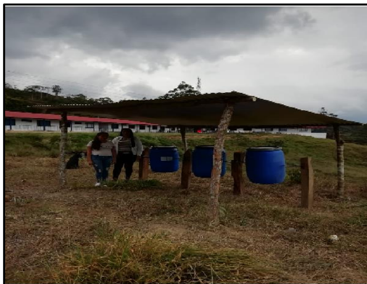
Imagen 6. Construcción de la caceta.
