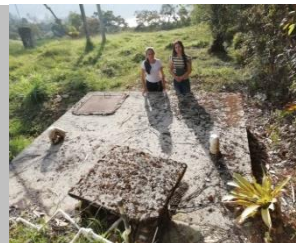
Imagen 22. Tanque de almacenamiento de agua enterrado.
