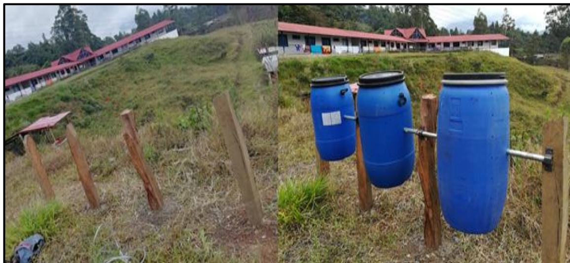
Imagen 5. Construcción e instalación del sistema de almacenamiento.
