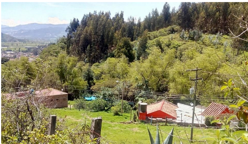
Figura 153. Invasión de Ronda Hídrica. Construcciones de casas. Fuente: Autor 2019.
