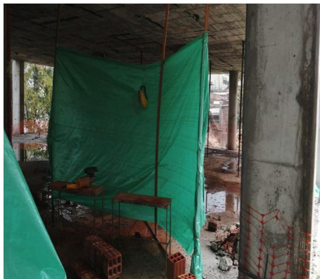
Imagen 36. Instalación de barreras de protección.
