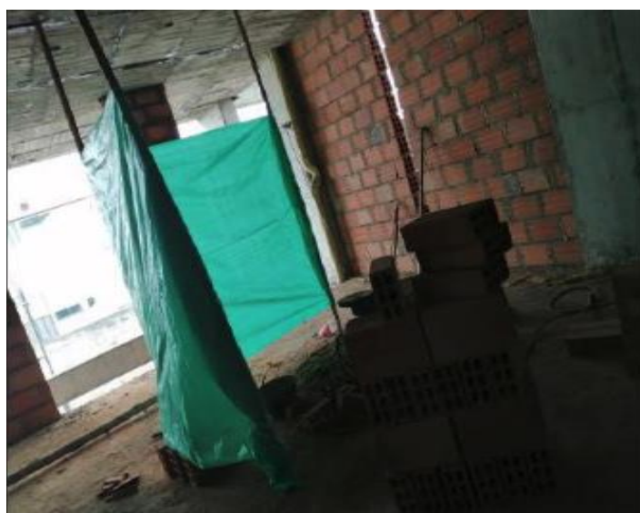
Imagen 37. Instalación de barreras de protección.
