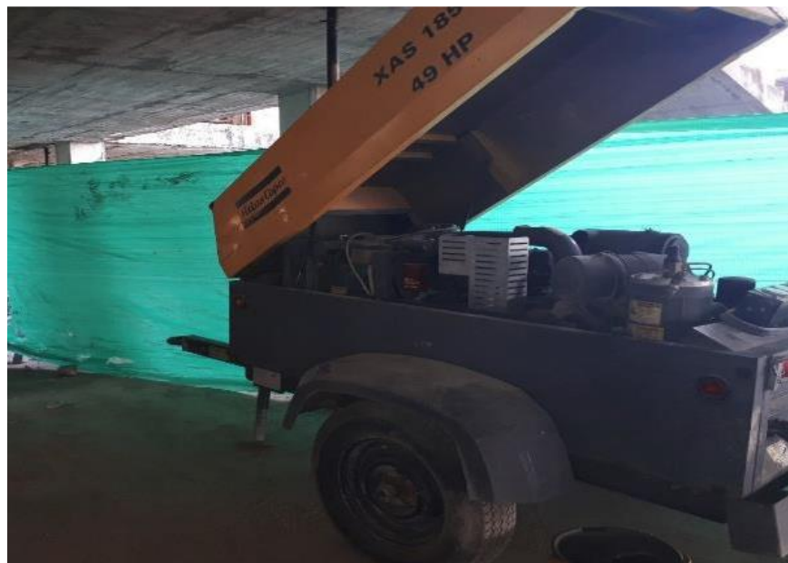
Imagen 39. Inspecciones pre operacionales
