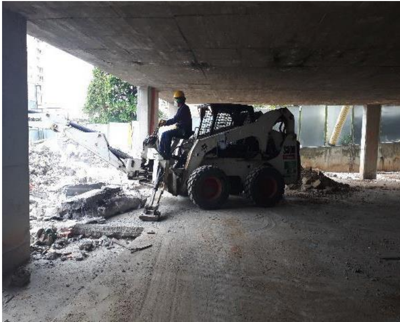
Imagen 40. Inspecciones pre operacionales
