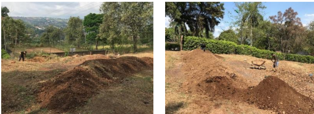
Imagen 63. Adecuación nuevo sitio para compostera
