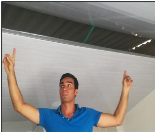
Fotografía 13 Instalación de Cielo Raso en PVC
