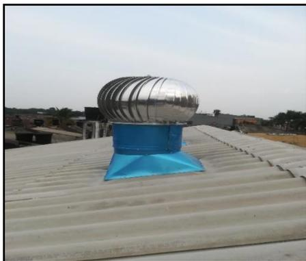
Fotografía 1 Extractores Eólicos JMO construcciones Malagon,O(2019)Extractores
