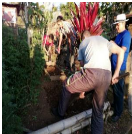
Imagen 26. Construcción de Semilleros (Garcia, 2019).
