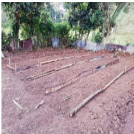
Imagen 27. Construcción de Eras o Camellones (Garcia, 2019).
