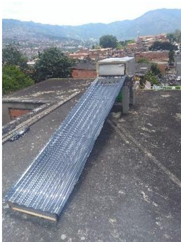
Imagen 6. Sistema ensamblado y habilitado para deshidratación híbrida – gas y panel solar.
