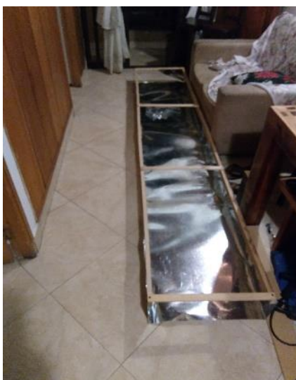
Imagen 2. Proceso constructivo del panel solar para deshidratación por convección
