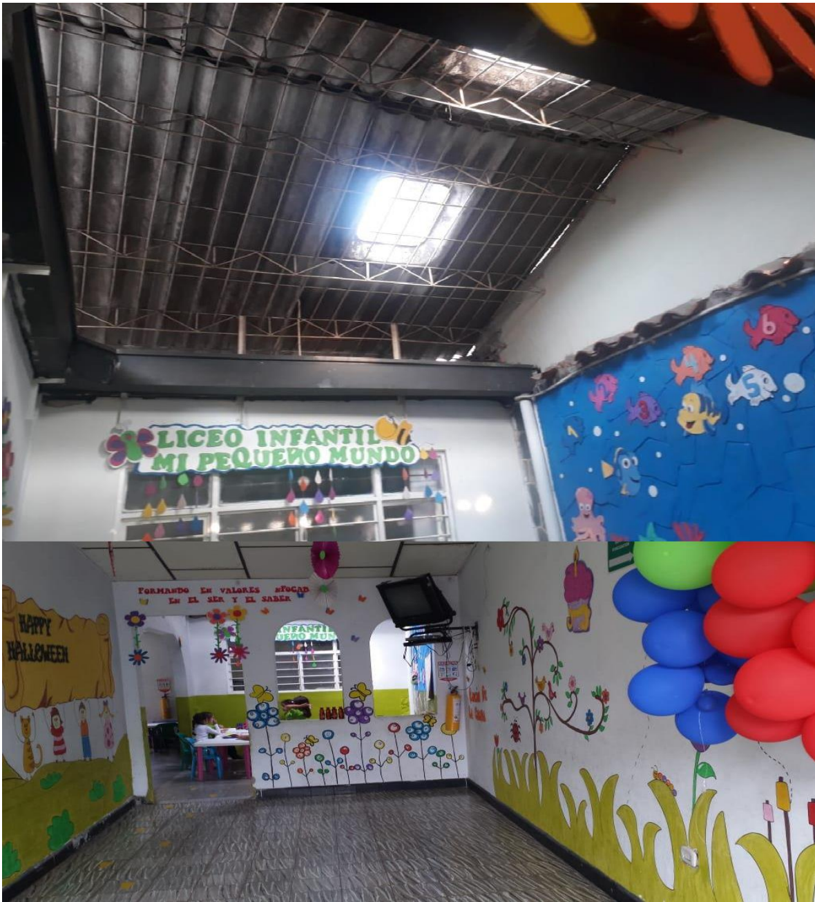
Fotografía Nro 2. Visualización de techo y salón de entretenimiento
