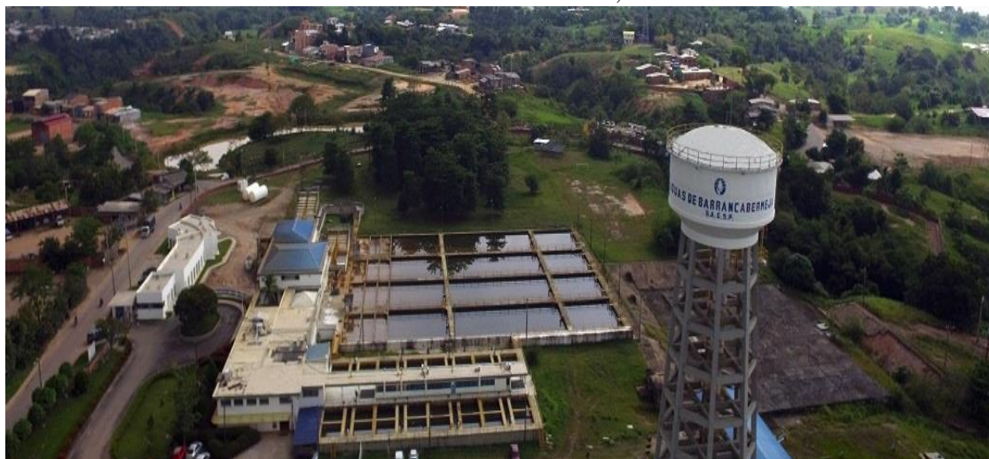
FIGURA 1. PTAP DE AGUAS DE BARRANCABERMEJA S.A., ESP.
