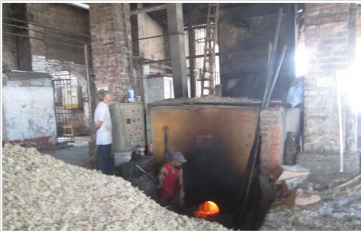
Area de alimentación horno, Fuente: Autoría propia, 2020.
