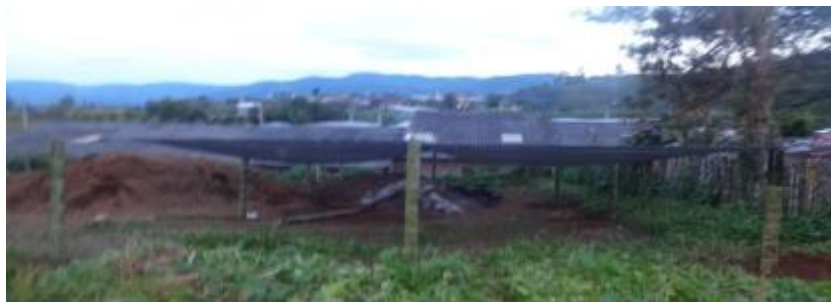
IMAGEN 21 Panorámica de Las Instalaciones del vivero
