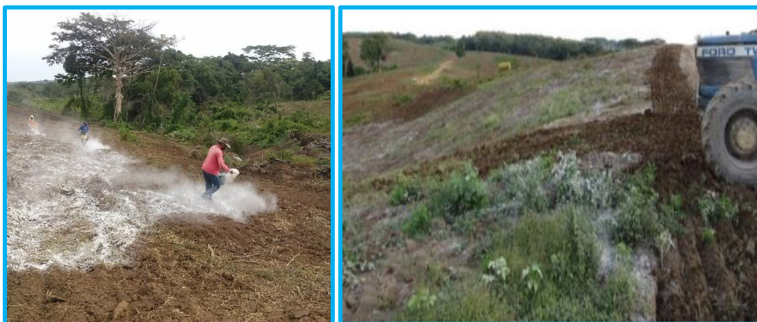
Figura 44. Aplicación de enmiendas. UOLG. Reforestadora de La Costa S.A.S. Municipio de Sabanas de San Ángel, Magdalena. (Fuente: El autor, 2019).
