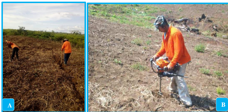
Figura 46. Proceso de ahoyado. (A) Manual. (B) Mecánica. UOLG. Reforestadora de La Costa S.A.S. Municipio de Sabanas de San Ángel, Magdalena. (Fuente: El autor, 2019).
