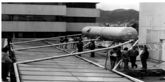
*Figura 3.* Calentador de la cafetería de la antigua Empresa de Energía de Bogotá (EEB).
