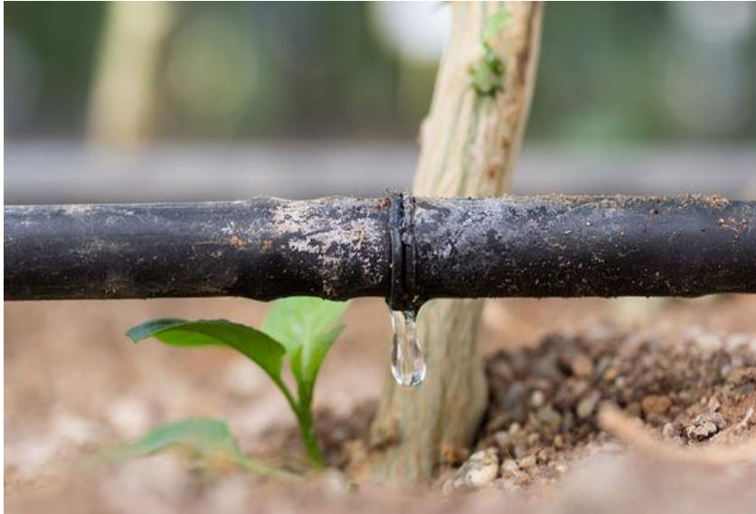
Ilustración 4 Uniformidad de caudal en el riego por goteo. Infoagro (2019)
