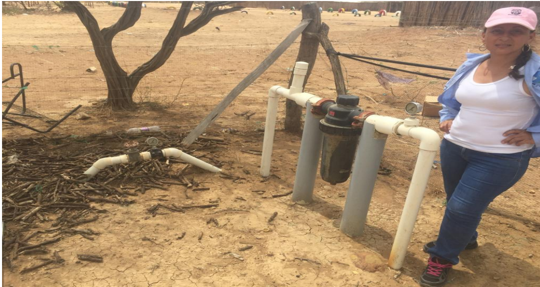
Ilustración 8. Sistema de filtración para el campo de riego. Joya (2019)
