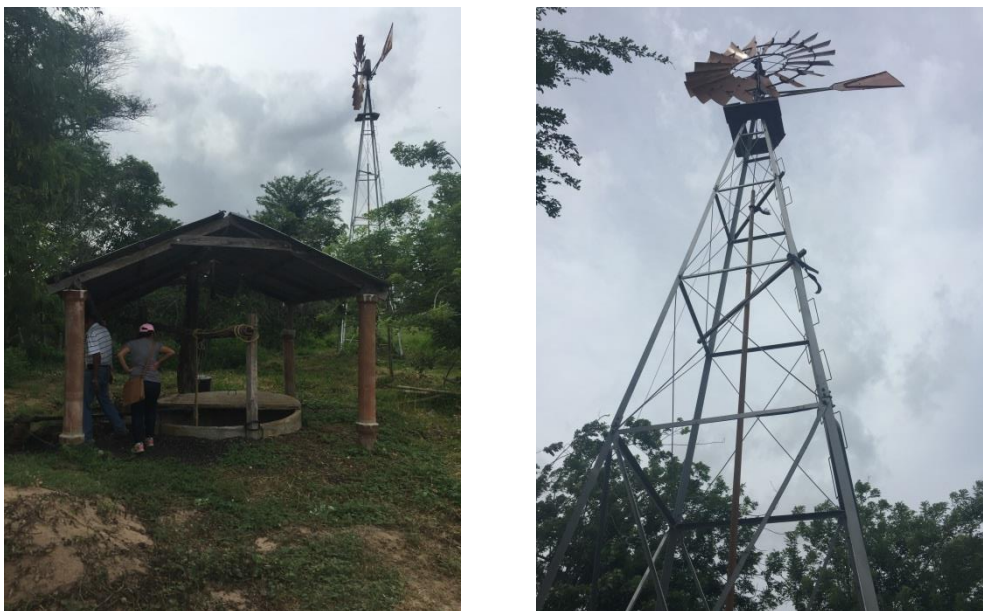
Ilustración 11. Fuente de agua para el riego de especies forestales en amenaza de extinción donde se utiliza un pozo profundo de 70 metros donde se utiliza la energía eólica. Joya (2019)
