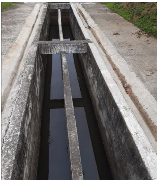
Ilustración 6 Desarenador
