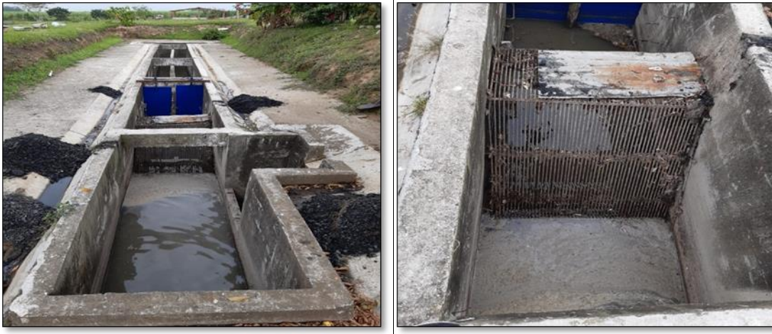
Ilustración 5 Rejilla de Limpieza Manual
