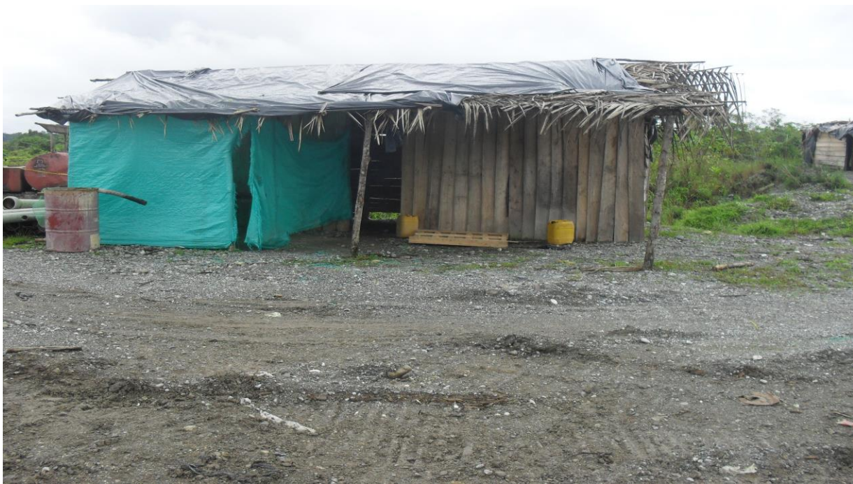
Sitio de almacenamiento de Combustible al aire libre
