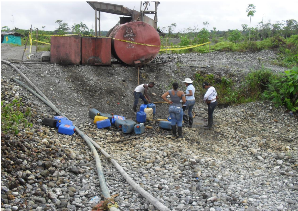
Diagnóstico previo de áreas degradadas por la minería en el corregimiento de Cértegui
