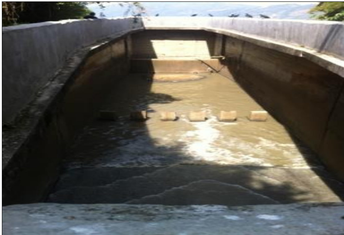
Figura 20. Estructura de Vertimiento Calle 6 – Aguas Arriba.
