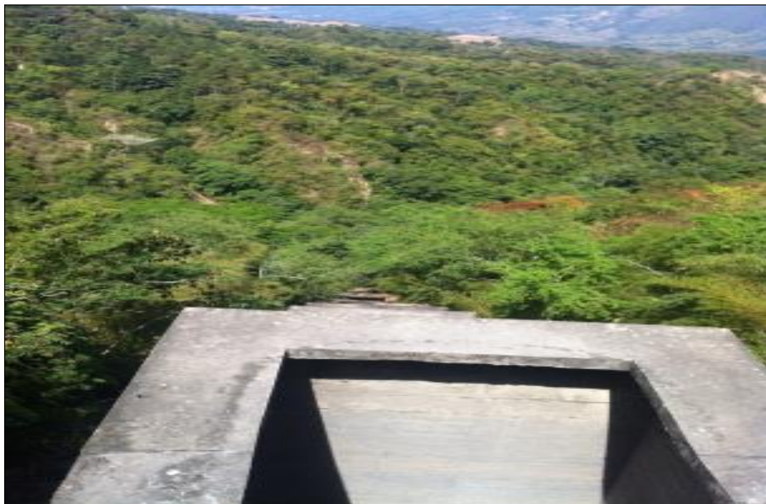
Figura 21. Estructura de Vertimiento Calle 6 – Tramo.
