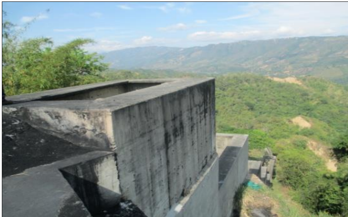
Figura 18. Estructura de Vertimiento Caney – Tramo.
