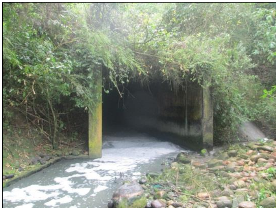
Figura 25. Estructura de Vertimiento Gaitán – Aguas Abajo.
