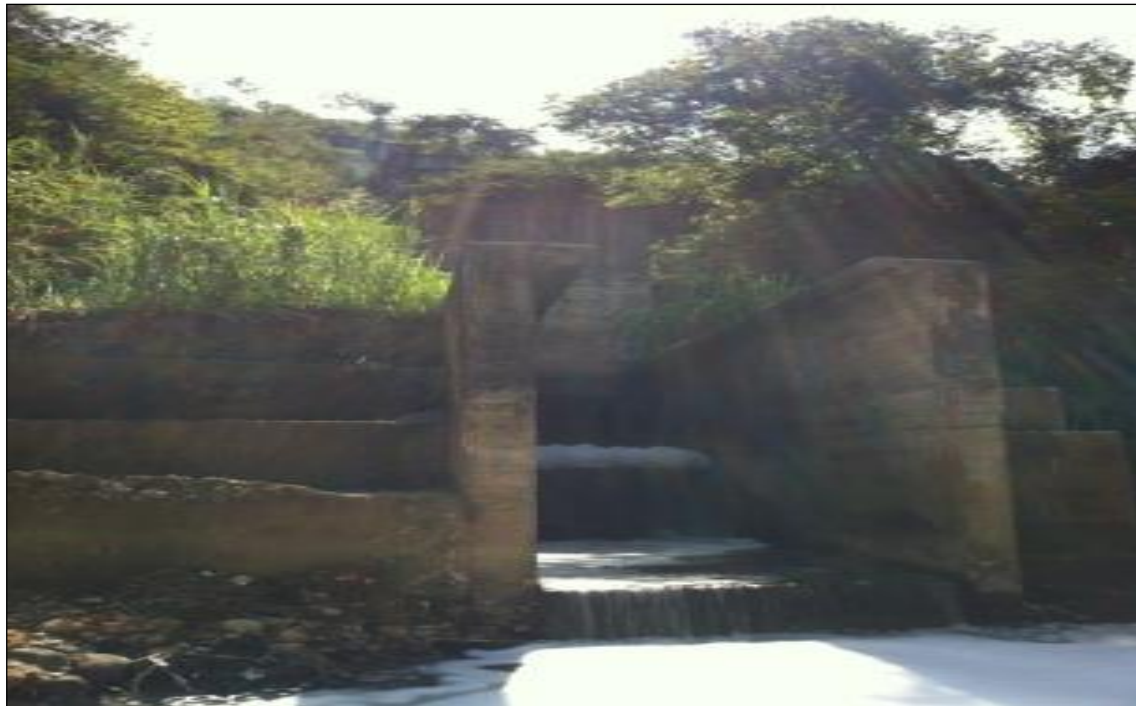
Figura 19. Estructura de Vertimiento Caney – Aguas Abajo.
