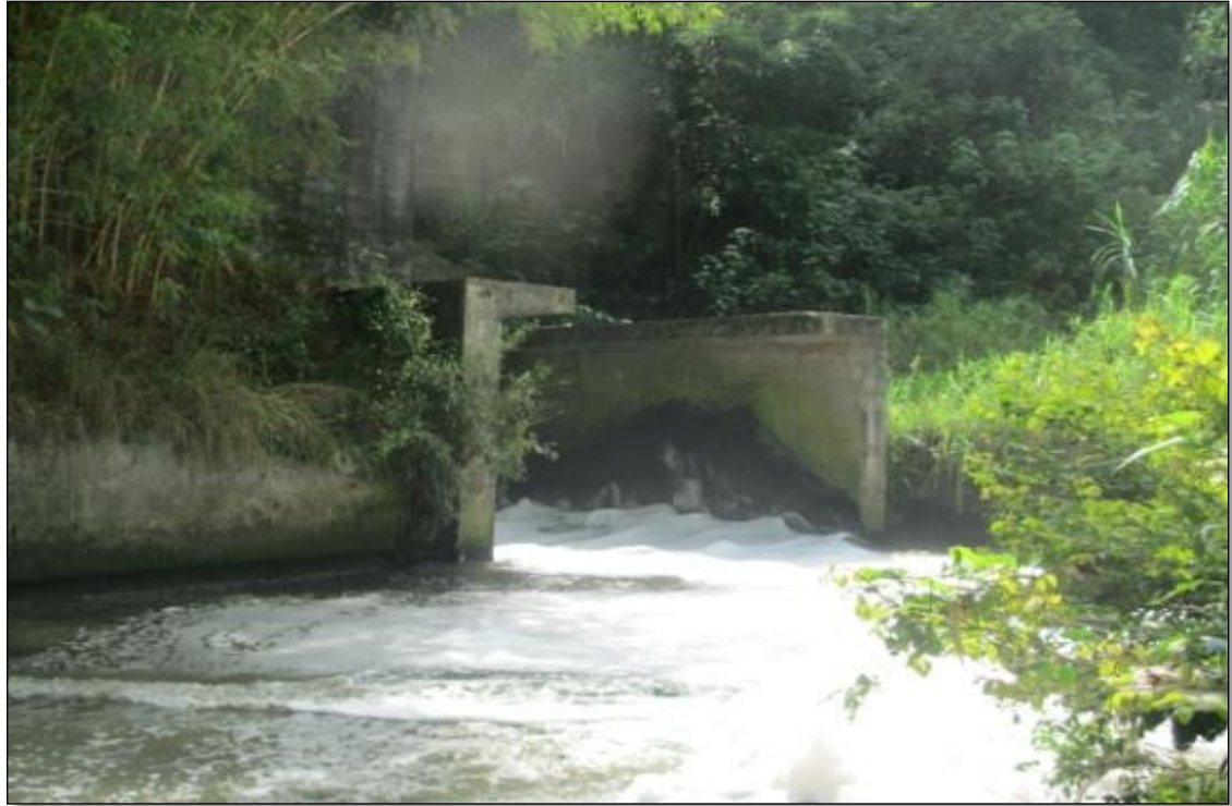
Figura 22. Estructura de Vertimiento Calle 6 – Aguas Abajo.
