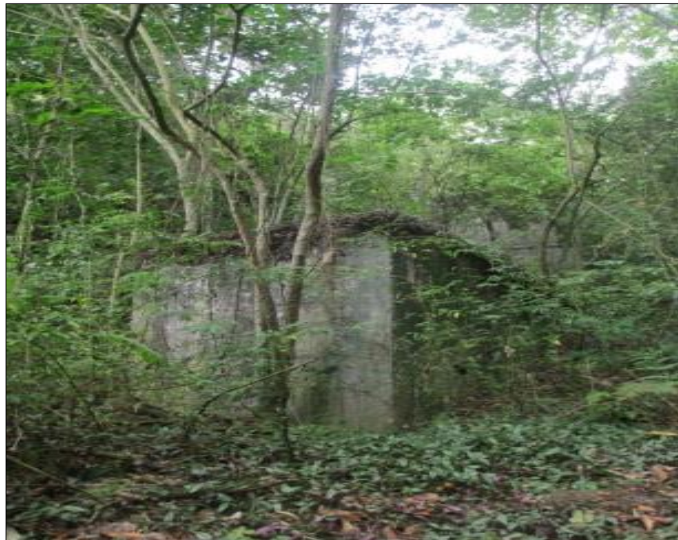
Figura 24. Estructura de Vertimiento Gaitán – Tramo.
