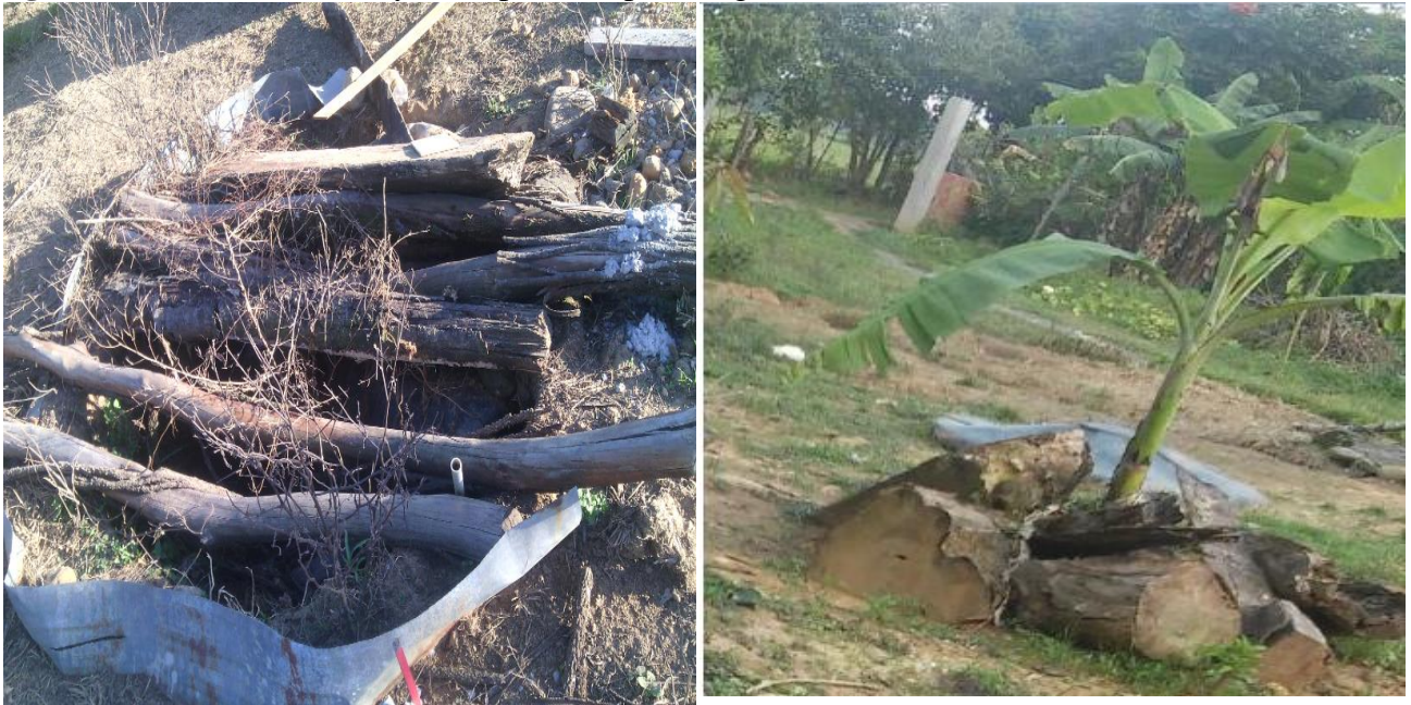
Figura 18: Muestra el antes y el después del pozo negro
