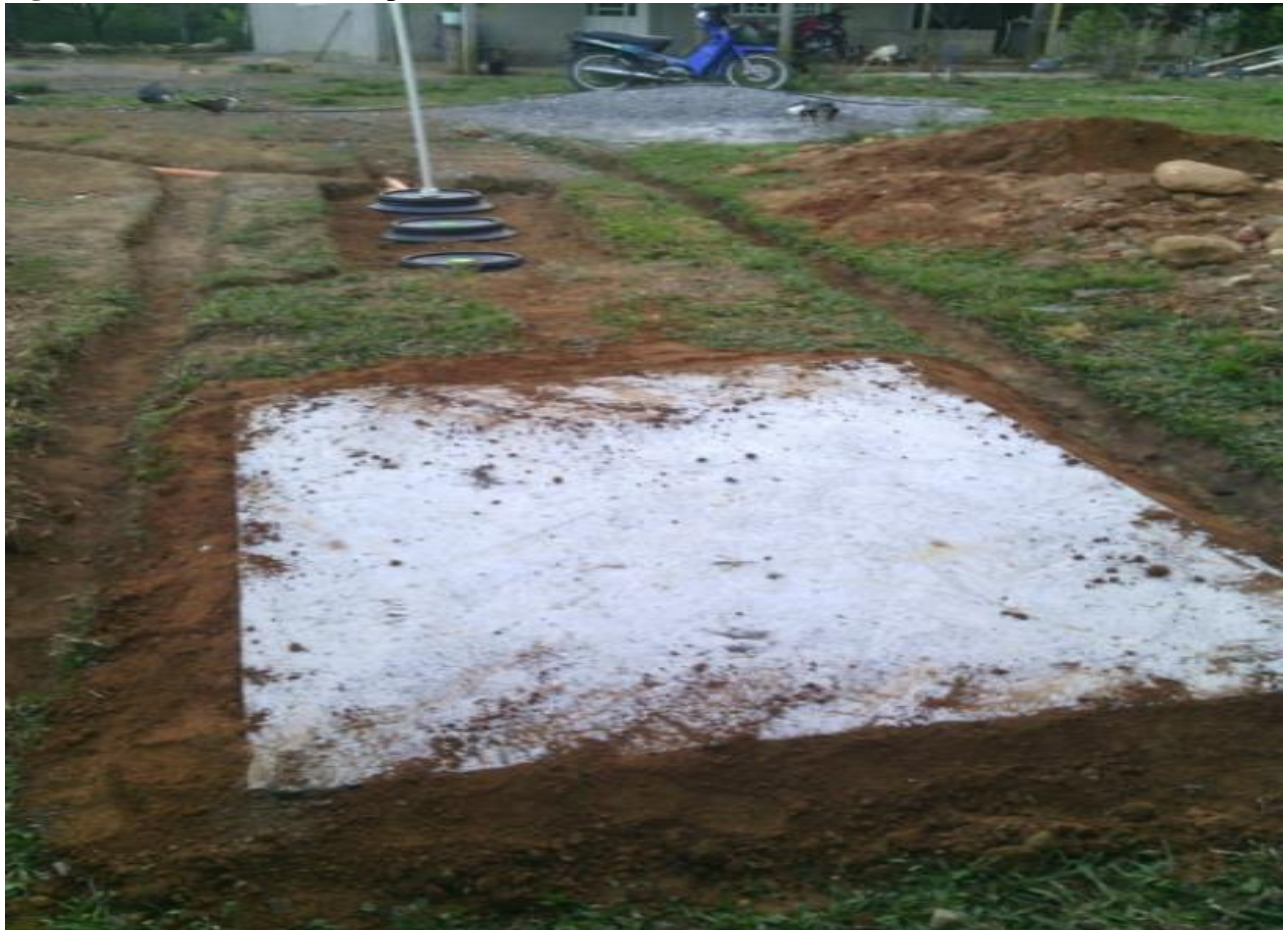
Figura 19: Sistema de fosa séptico funcionado
