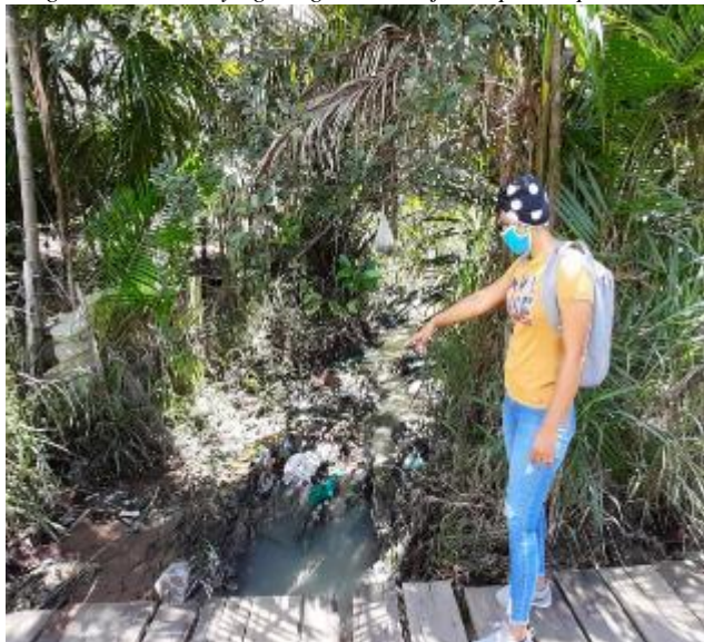
Imagen 4. Residuos y aguas grises debajo del puente peatonal.
