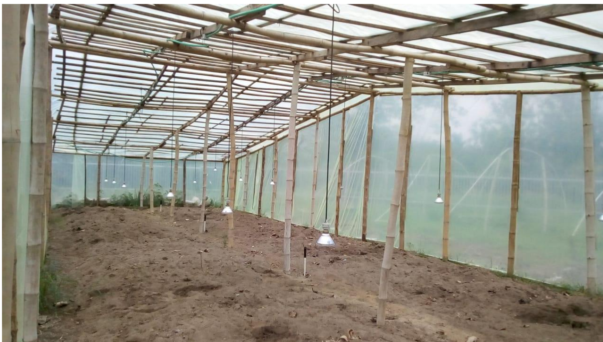
Cámara térmica interior
