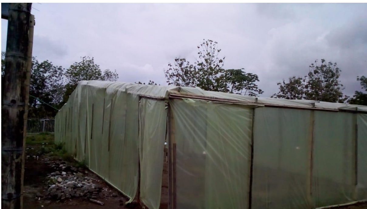
Cámara térmica exterior
