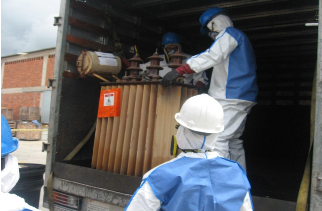
Figura 7. Transporte de equipos eléctricos a bodegas 2
