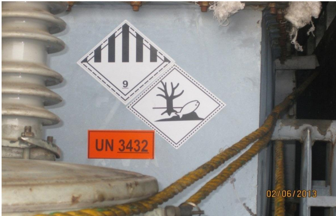
Figura 6. Transporte de equipos eléctricos a bodegas
