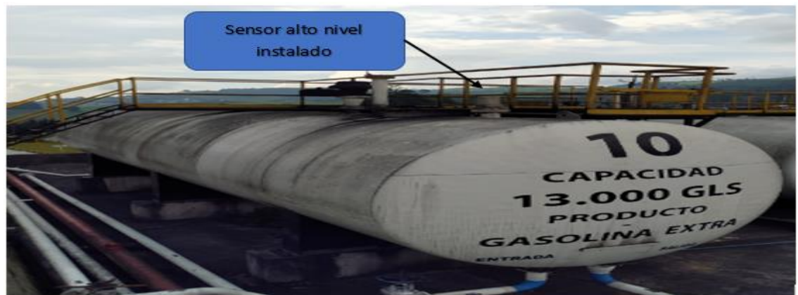
Tanque numero 10 despues de la instalación del sensor de alto nivel
