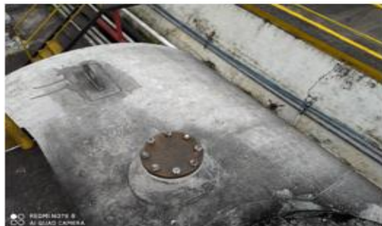
Tanque antes de la instalación
