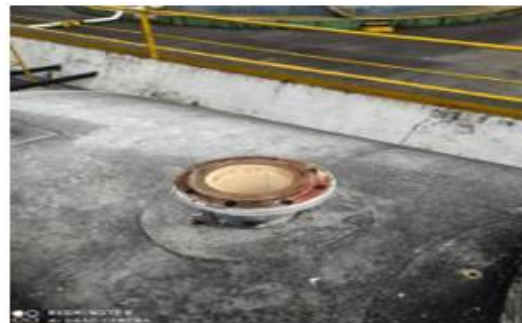
Desmonte de la brida acero al carbón
