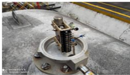
Cableado y conexión.
