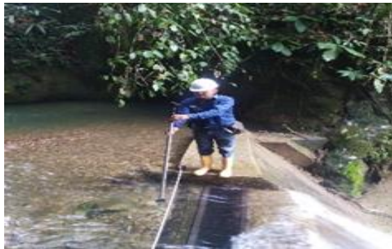
Figura 9. Aforo en bocatoma rio Chitamena
