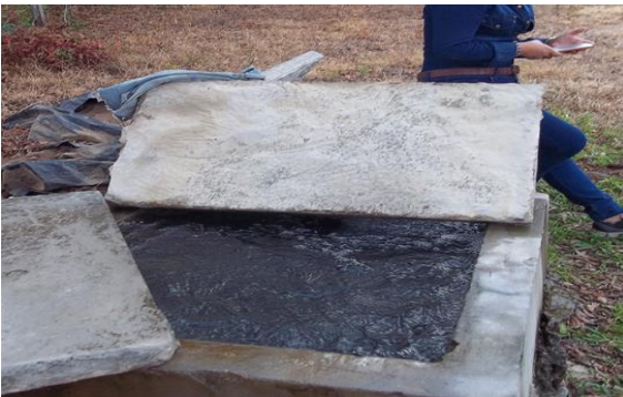
Figura 27. Cámaras de quiebre. Fuente: Autor
