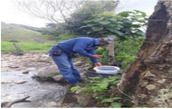
Figura 10. Aforo realizado en la fuga del empalme. Fuente: Autor
