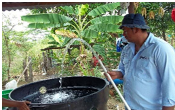
Figura 33. Acometida sin medición. Fuente: Autor
