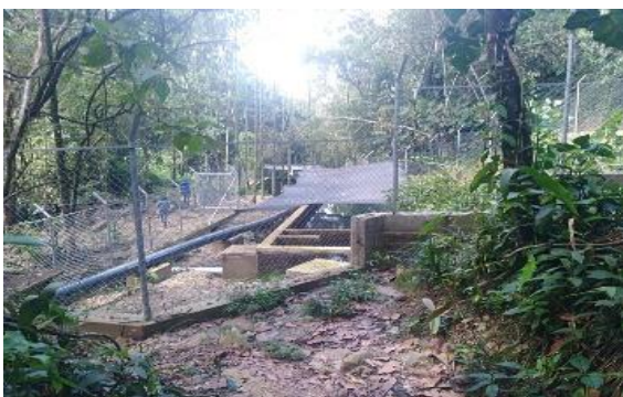
Figura 5 Desarenador en construcción
