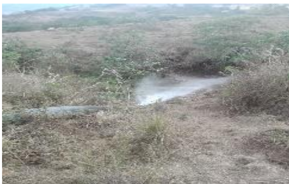
Figura 9 Fuga de empalme línea de conducción. Fuente: Autor
