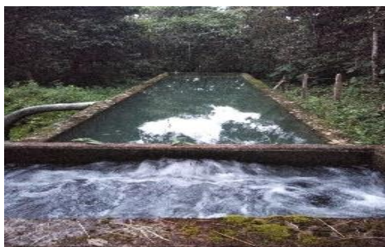
Figura 6 Desarenador en funcionamiento
