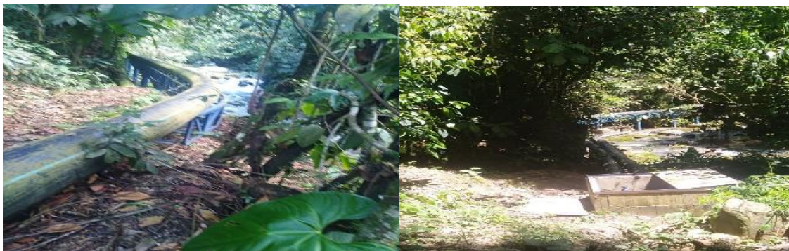
Figura 6 Línea de Aducción. Fuente: Autor
