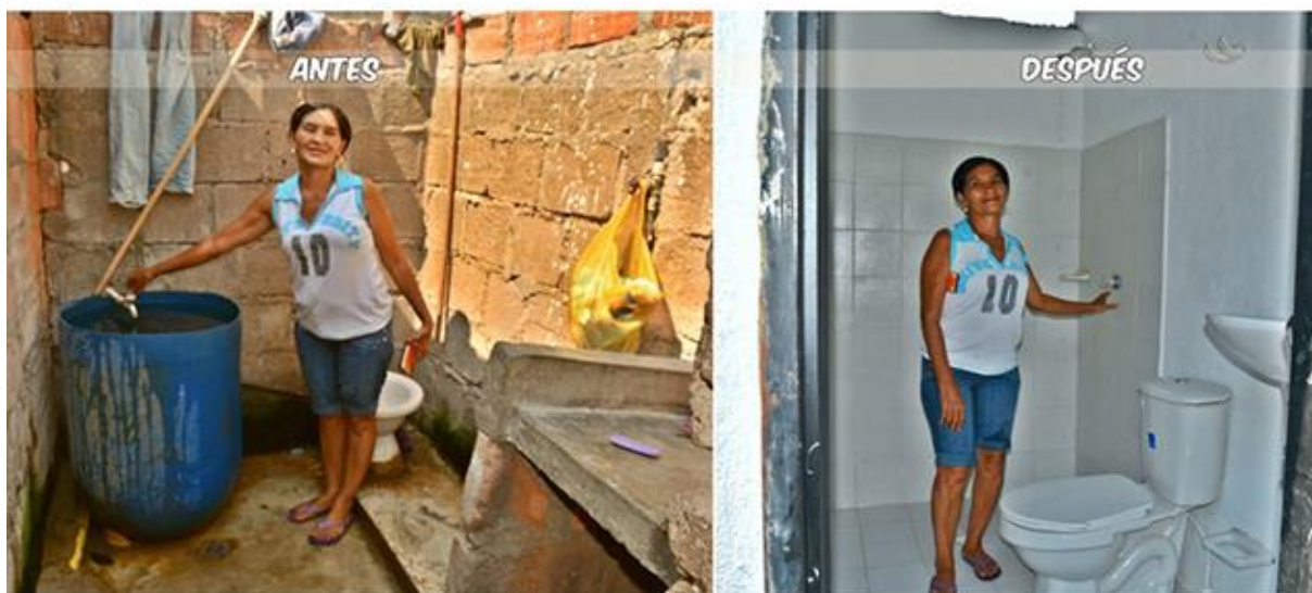
Figura 1. Instalación Conexiones Intradomiciliarias-Becerril Cesar-Antes y Después Foto: Comfacsar. Tomado de: https://www.maravillastereo.com/81-familias-de-becerril-recipientes-conexiones-intradomiciliarias/
