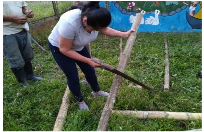
Ilustración 31 construcción del punto ecológico con algunos padres de familia en la escuela El Macal sede Liceo sur andino
