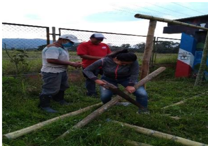
Ilustración 32 corte de guadua para estructura. Fuente: Autoría propia.
