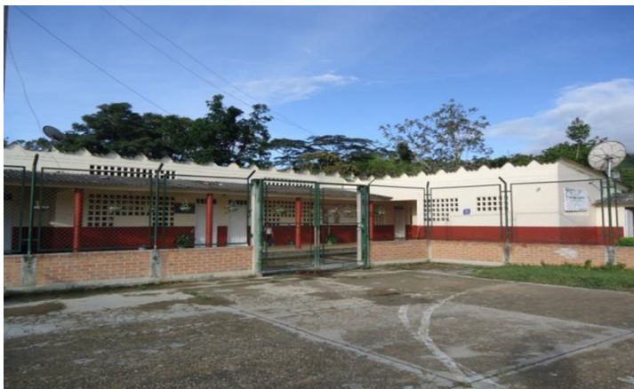
Ilustración 15 Sede escuela El Macal. Fuente de autoría propia
