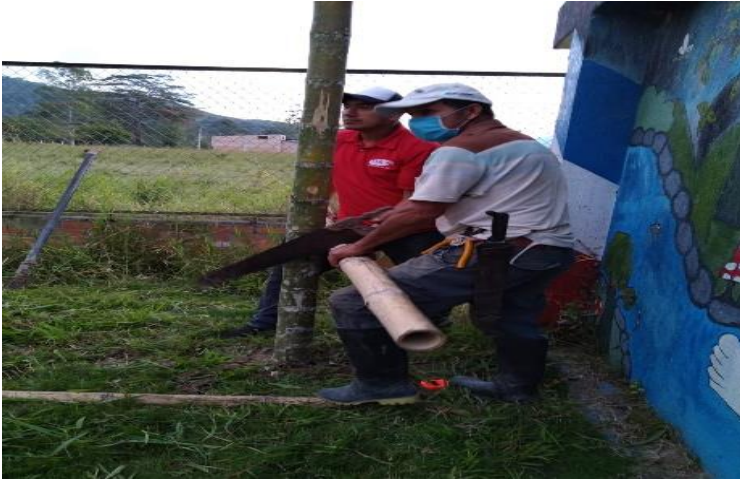
Ilustración 30 construcción del punto ecológico con algunos padres de familia en la escuela El Macal sede Liceo sur andino
