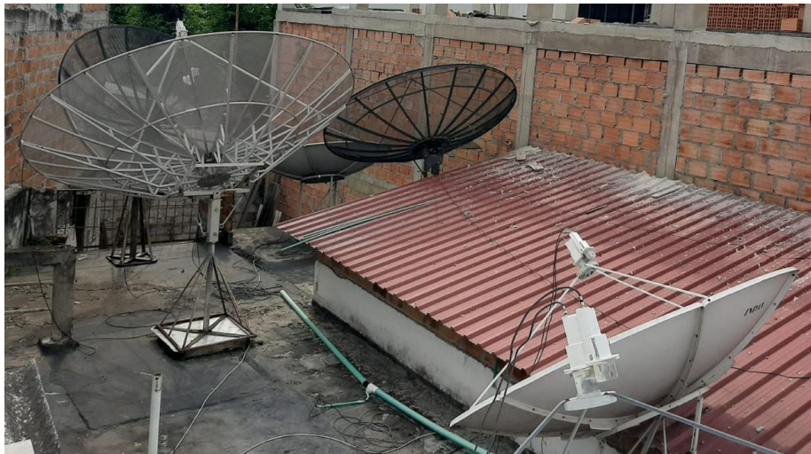
Figura 1. Antenas de la empresa Mecatronics
