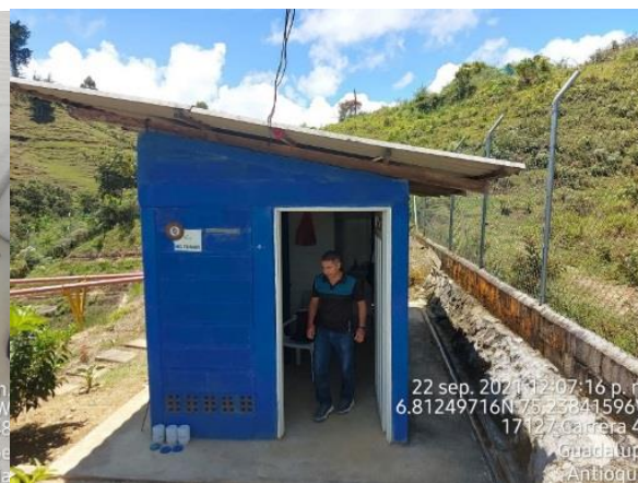
Caseta/oficina e insumos
