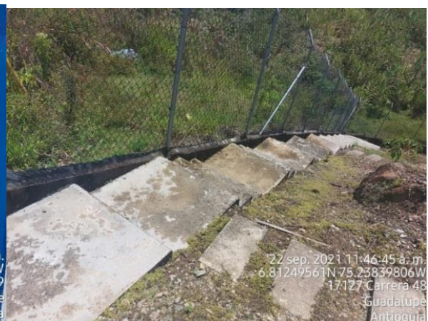
Vías de acceso
