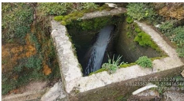
Caudal sobrante - vertedero de excesos
