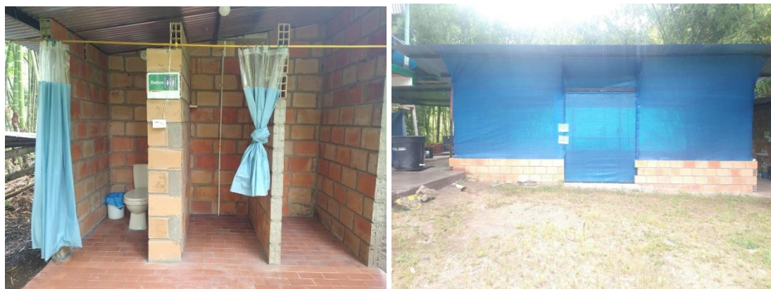
Figura 4 Adecuación de infraestructura
