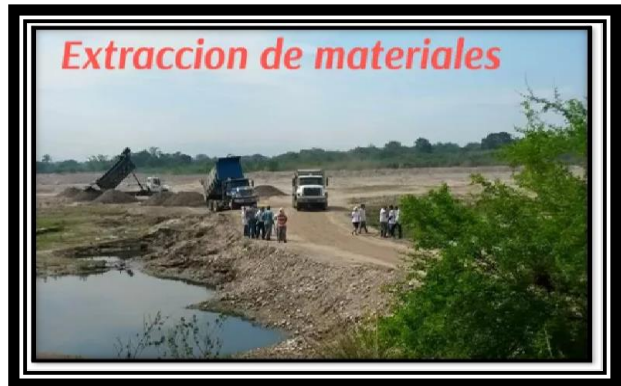
Ilustración. Extracción de materiales río Saldaña.
