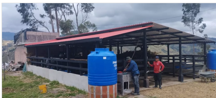
Figura 2. Tanques de almacenamiento de agua.
