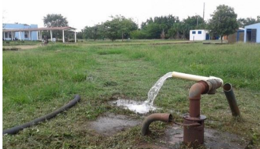
Figura 2. Imagen pozo de captación de la PTAP. Fuente: autor
