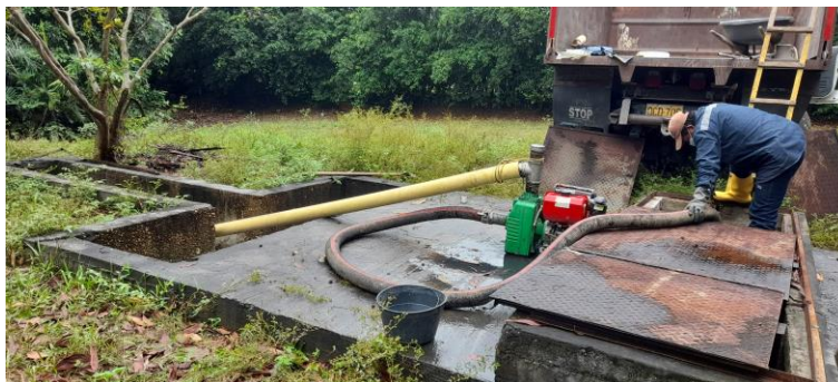
Figura 17. Mantenimiento canal de entrada a la PTAR. Parte 2
