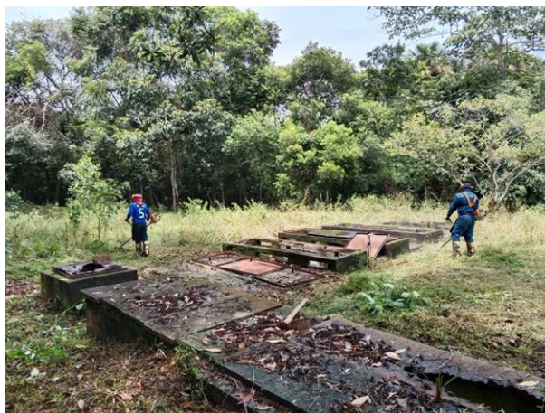
Figura 18. Mantenimiento canal de entrada a la PTAR. Parte 3
