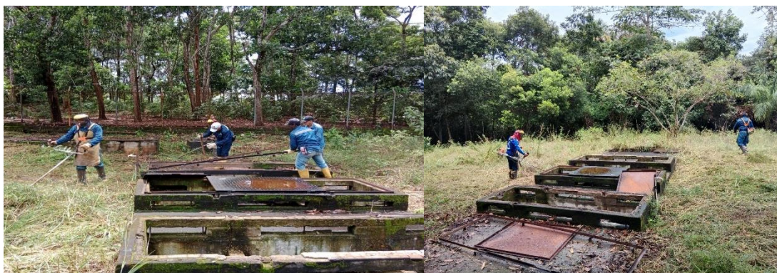
Figura 23. Retiro de las estructuras metálicas
