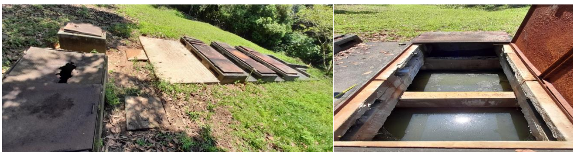
Figura 4. Vista general de la PTAR
