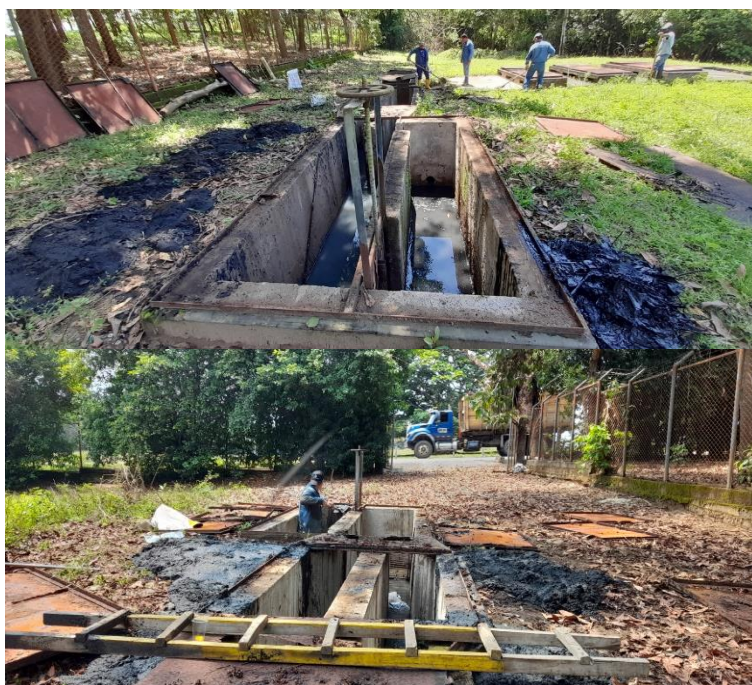
Figura 16. Mantenimiento canal de entrada a la PTAR. Parte 1
