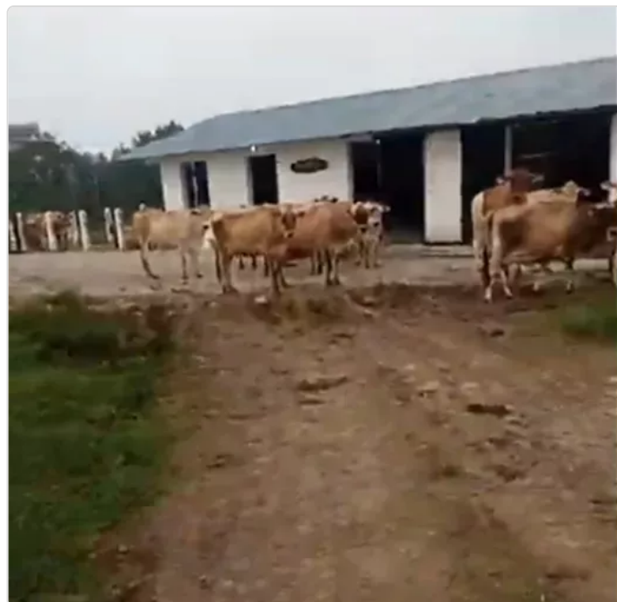
Figura 3 Instalaciones, Sala de Ordeño Finca El Hato
