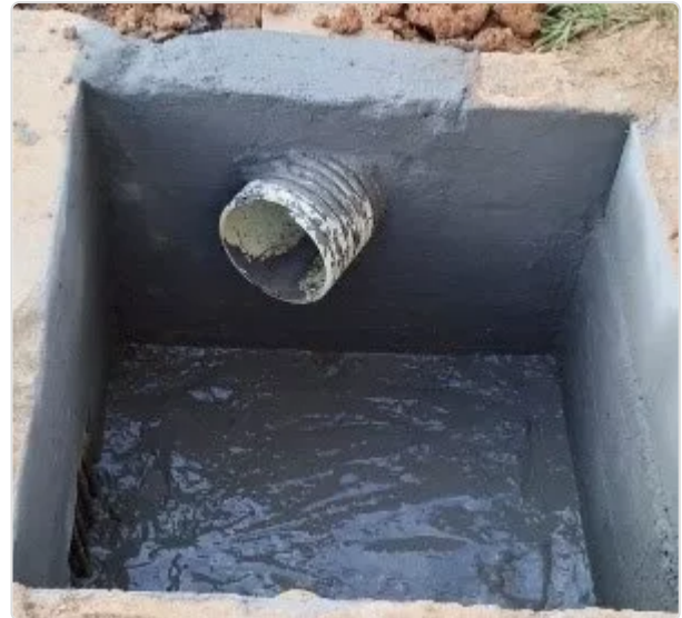
Figura 4. Eliminación de excretas sólidas
