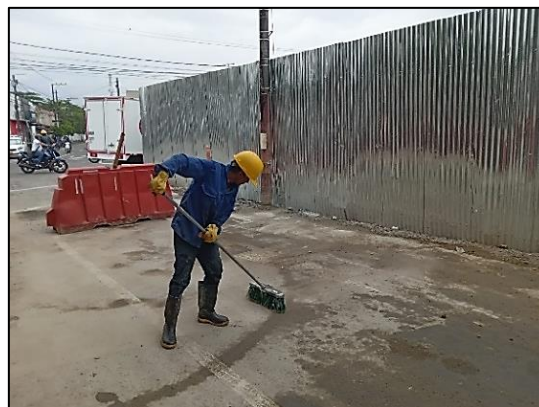
Limpieza de piso de fundida
