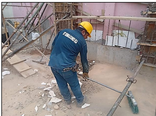
Limpieza de area de trabajo donde se realiza corte y figurado de hierro.
