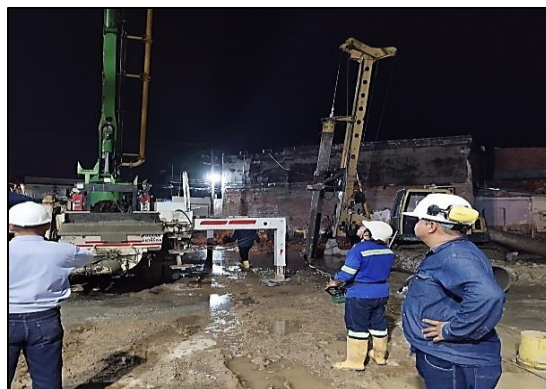
Fundida de pilotes con mezcla de concretera mediante motobomba.
