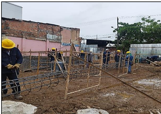
Armado y figurado de hierro in situ.
