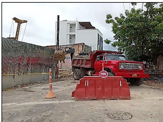
Cargue de material producto de excavaciones preliminares.
