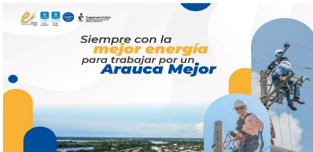
Figura 9: Trabajos en alturas.
