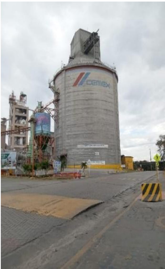
Silo de 60000 toneladas
