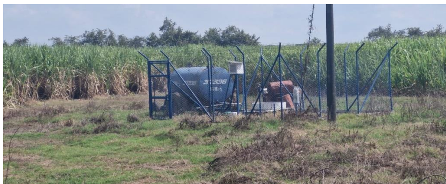
Estación meteorológica bocas del palo
