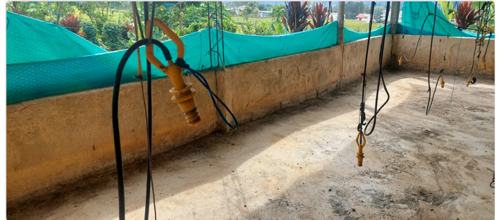
Figura 6. Muros de aislamiento
