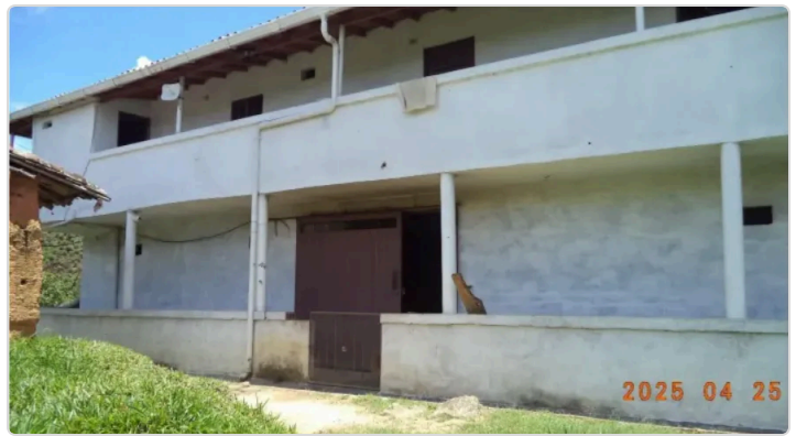
Figura 2. Casa segundo y primer piso
