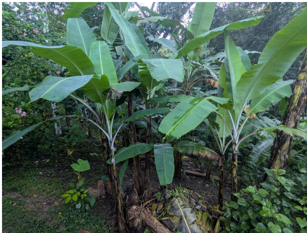
Figura 9. Sistema de tratamiento de aguas grises “Círculo de plataneras”
