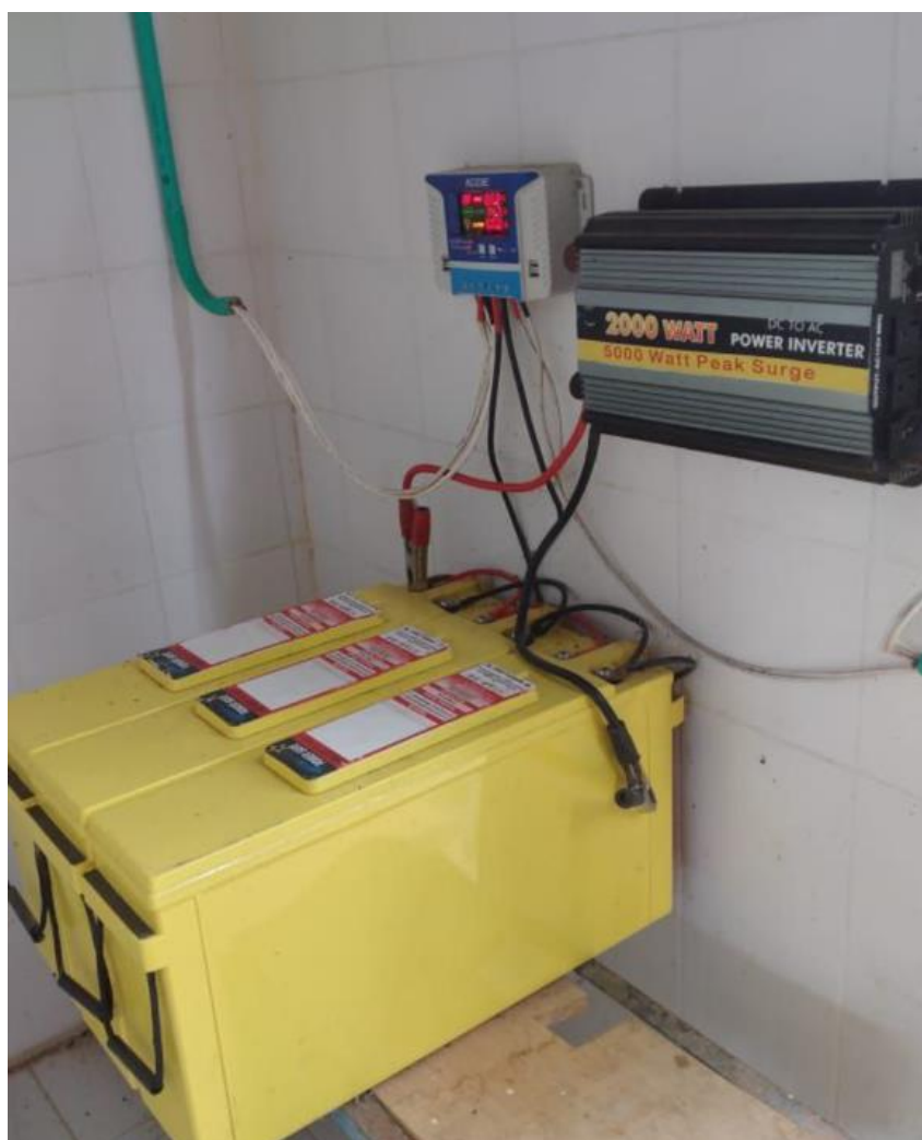
Figura 12. Sistema fotovoltaico con paneles solares
