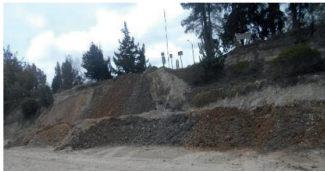
Imagen 5. Patio de acopio
