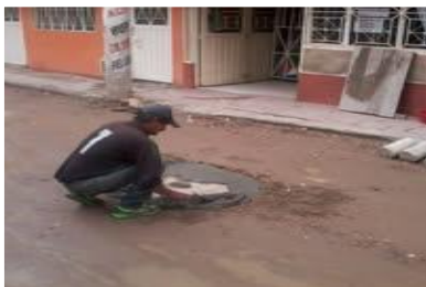
Arreglo de vías
